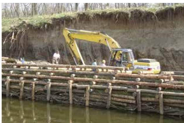
Eine umfangreiche Sanierung des Thaya-Damms erfolgte im Jahr 2003. Dabei führte das Amt der NÖ Landesregierung ingenieurbioologische Ufersicherungsmaßnahmen im Flussbett durch. An besonders gefährdeten Stellen an der Wasserlinie wurden Holzpiloten in das Erdreich getrieben und die Zwischenräume mit Weiden und Erde aufgefüllt. Die Weiden sind im Laufe der Jahre mit dem Ufer verwachsen und stabilisieren dadurch nun den Damm. ■
