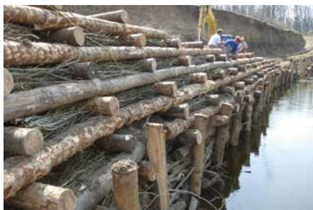
Außerdem wurden im Bereich des Ruhhofs Sanierungsmaßnahmen am Damm des Thaya-Mühlbachs gesetzt. In diesem Bereich wurde der Damm verbreitert und gegen die Ansiedlung von Nagetieren geschützt. Auch beim Bockgraben wurde die Wehr saniert. Die Südumfahrung von Laa wurde nicht nur als eine Umfahrungsstraße sondern auch als eine Schutzmaßnah-
