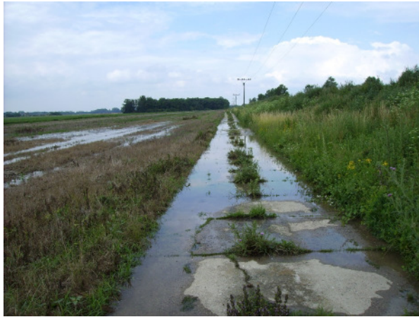
Weg entlang des Thayadammes in Tschechien. Die Wasserflächen sind nur durch Sickerwasser aus dem Damm entstanden (2006).
