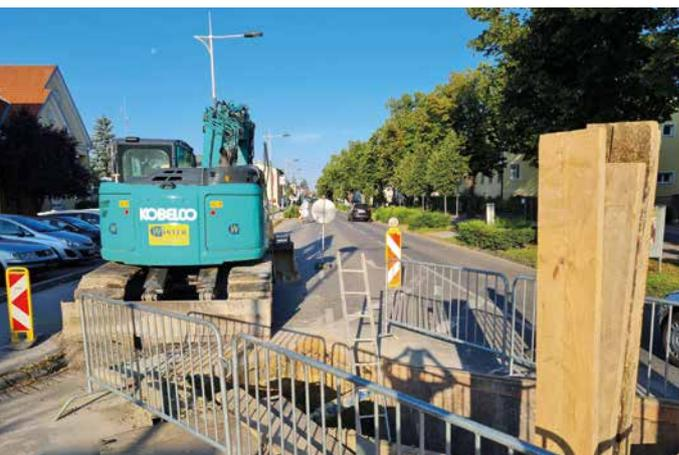
Im Bereich der Staatsbahnstraße – Kreuzung Kindergartenstraße wurde der Kanalschacht saniert. Im Zuge dieser Tätigkeiten bereinigte man auch die Einmündungssituation. Durchgeführt wurden die Arbeiten im Auftrag der Stadtgemeinde Laa von der Firma Leithäusl. ■
