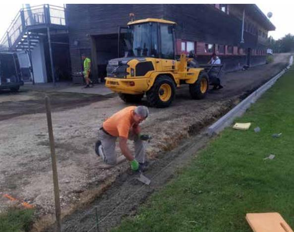
Die Zufahrt zu den Kabinen des Laaer Sportplatzes wird derzeit gepflastert. Der Städtische Bauhof errichtet hier den Unterbau sowie die Anlagen für die Entwässerung, setzt 160 Laufmeter Randleisten und stellt das gesamte Material zur Verfügung. Das Setzen der Pflastersteine wird durch den SC LAA vorgenommen. Das Oberflächenwasser wird aufgefangen und in weiterer Folge zur Bewässerung der Plätze genutzt. ■
