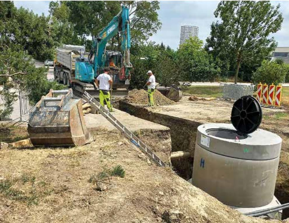
Im Zuge der Vorarbeiten zum Bau des Regenwasserkanals im Bereich Mühlweg wurden vor kurzem die Arbeiten an der Sanierung der Trinkwasserleitung abgeschlossen. In diesem Zuge wurden 17 Hauptschieber sowie T-Stücke und viele weitere Armaturen erneuert, da dieser Trinkwasserring die Haupt-
