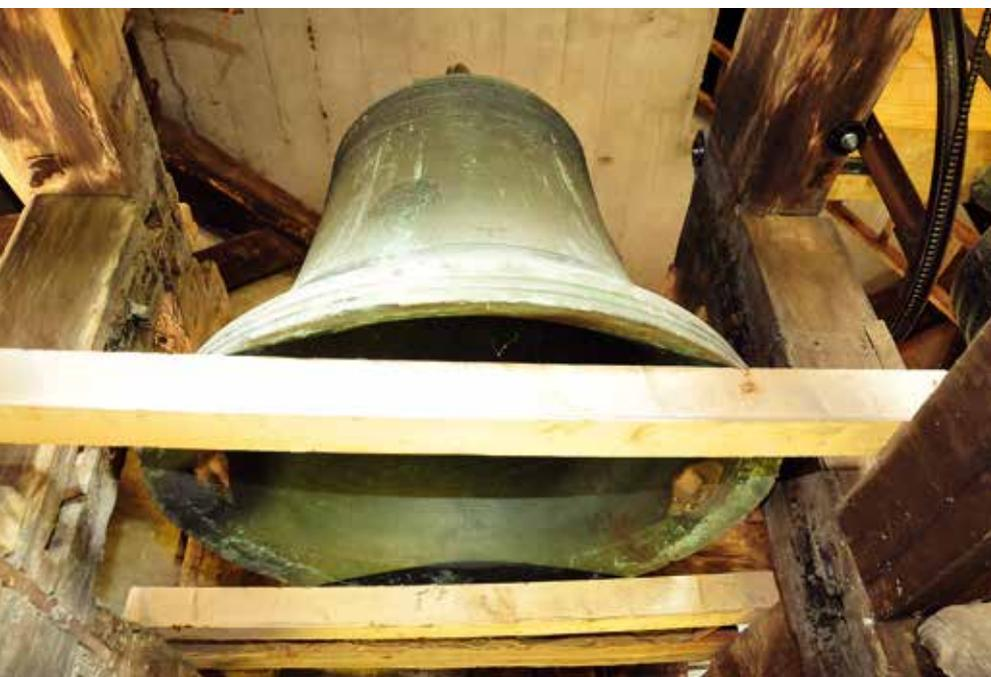
Nach einer längeren Planungsphase und dem Abschluss der Vorbereitungsarbeiten wurde nun die Komplett-sanierung der Glocken der Stadtpfarrkirche und der Kirchturmuhre durchgeführt. Die Sanierung umfasste vier neue Holzjoche, einen neuen Teil-Glockenstuhl, drei neue Klöppel, die Neu-Elektrifizierung, eine neue Glockensteuerung und die Erneuerung der Turmuhr. Mehr als 250 Stunden arbeiteten die vier ehrenamtlichen Glockenmonteure Hans
