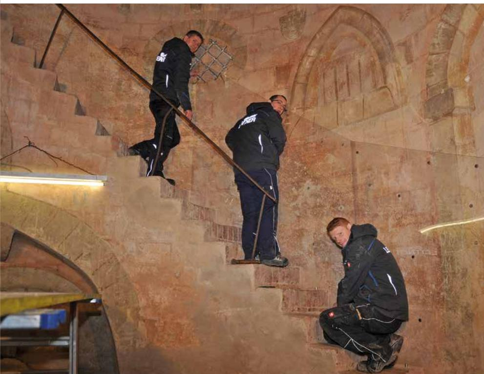
In den Wintermonaten wurde der Aufgang in das Obergeschoß neu hergestellt. Da durch die kalte Witterung keine Maurerarbeiten möglich waren, wurde die Zeit genützt, um den bestehenden Betonboden samt darunter befindlichem Schutt im Erdgeschoß des West- und Nordtraktes zu entfernen. Das Biermuseum im Südtrakt wurde mit einer neuen Zuleitung an die im Vorjahr erneuerte Stromzuleitung angeschlossen. Diese Arbeiten wurden von den Mitarbeitern des Städtischen Bauhofs ausgeführt.
