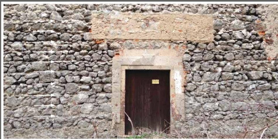
An der Ostmauer der Laaer Burg lassen die Baulinien mit einer Höhe von 30 bis 40 cm, die eine spezifische Mauertechnik des 13. Jahrhunderts darstellen, auf eine Bauzeit um 1230 schließen.
